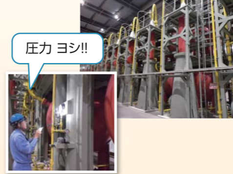
高圧の作動油を一時貯めておき、主油圧ポンプユニットと共に加振機へ送ります。
