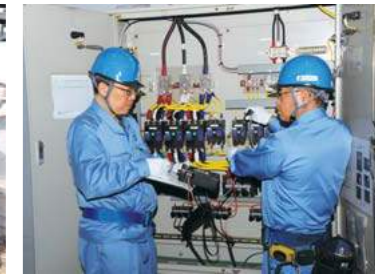
■作業用電源盤漏電遮断機の点検
