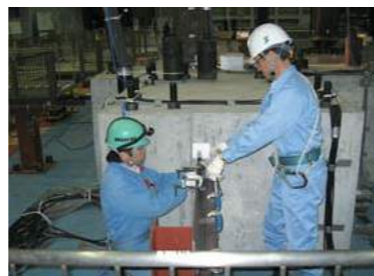
■計測センサーの取付
